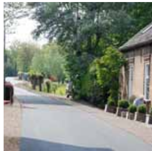
koppelstrook zorgt voor overgang van rijloper naar gevel, erf, tuin of talud. Beeld: reconstructieplan dijk Slingeland.
