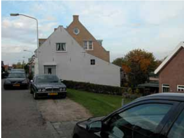
Uitbreiding door verlengen kap
