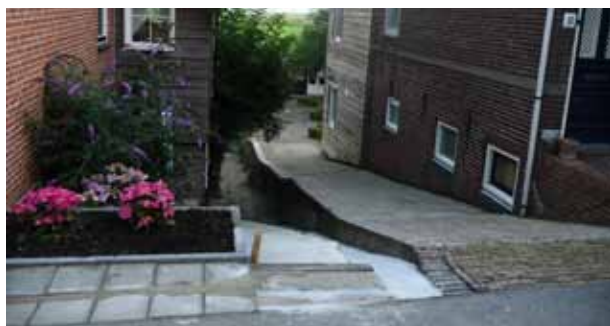
Afwatering langs trap en helling naar beneden.
