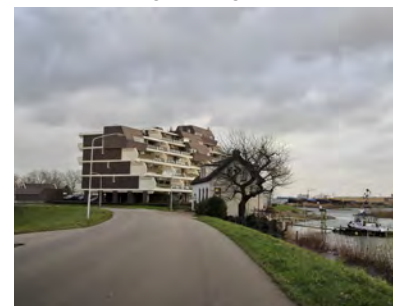
Uitzondering is het grootschalige appartementengebouw Huys de Merwede
