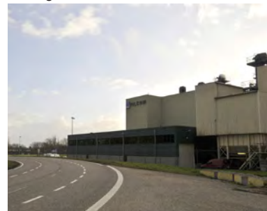
Gebouwen zijn individueel, afwisselend en eenvoudig van opbouw
