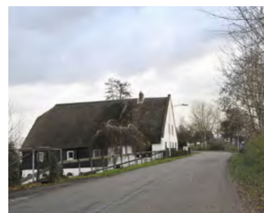
De hoofdmassa is op kruinhoogte gesitueerd
