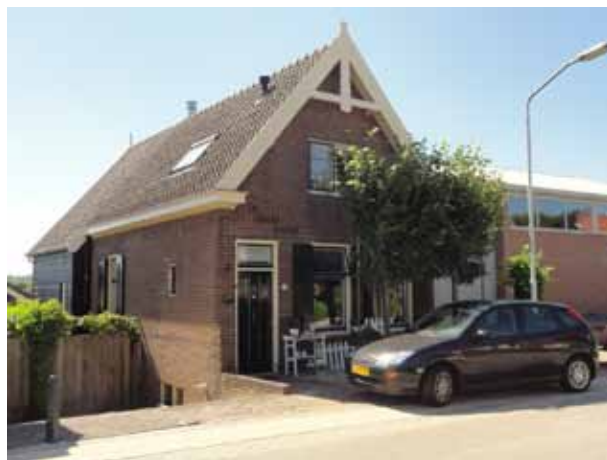
Uitbreiding door in lengterichting doortrekken kap
