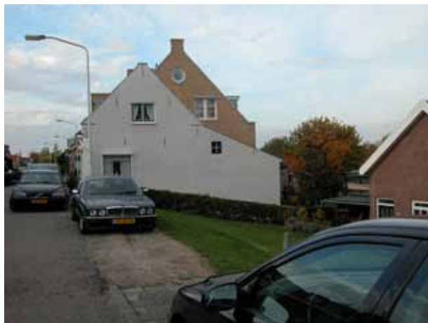
Uitbreiding door verlengen kap
